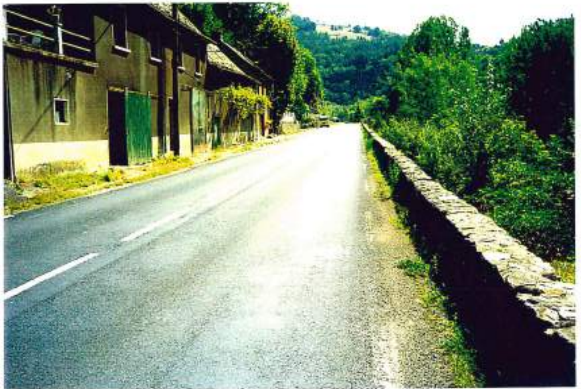
48-10 (n°27-2°-3) - La N9 au lieu-dit Flouret, carrefour avec la C2 direction Auxillac : chaussée de 5,50m, aucun espace pour les cyclistes, danger
