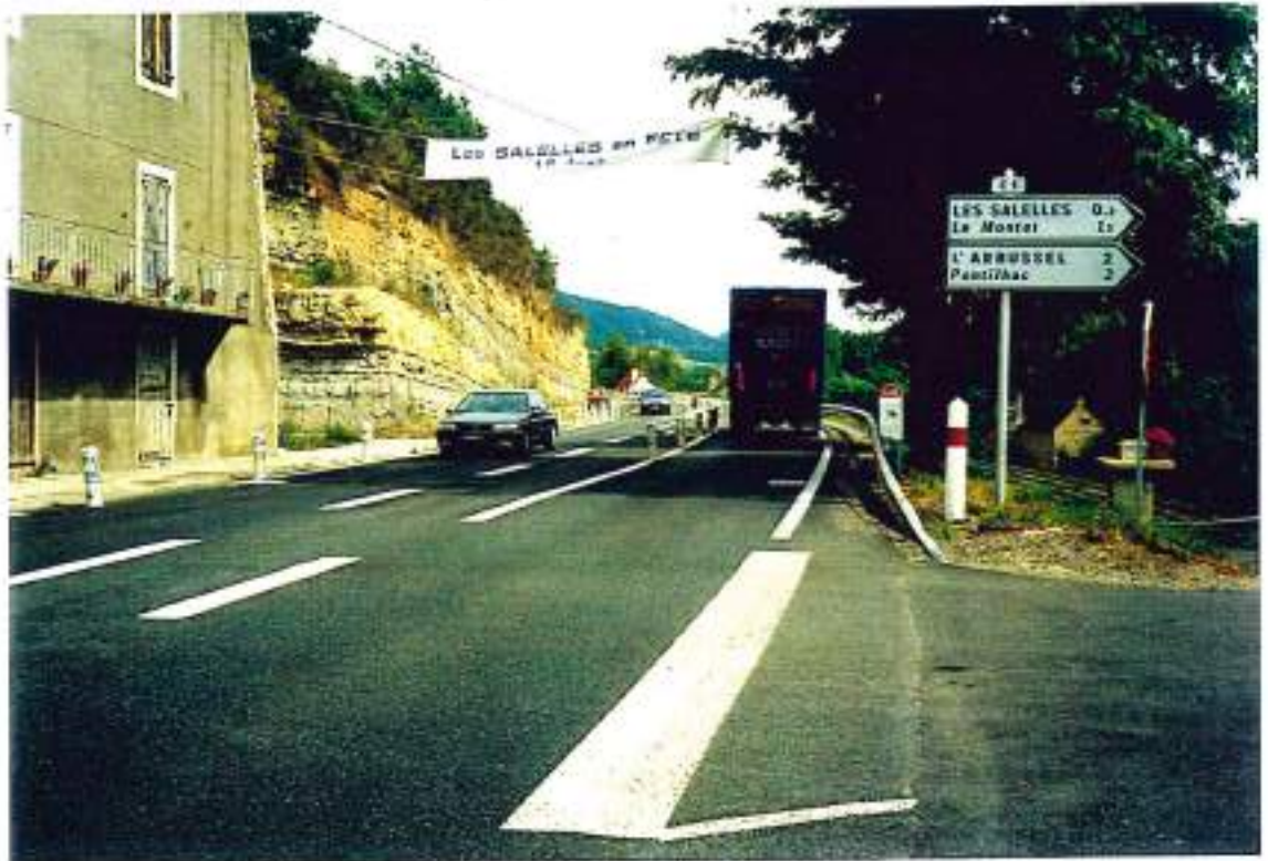
48-11 (n°27-2°-5) - La N88 au carrefour de Les Salelles : chaussée rétrécie (tourne - gauche), passage très dangereux pour les cyclistes
