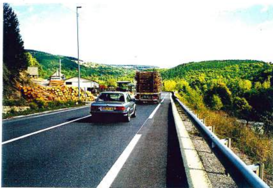
48-36 (n°32-16) - La N88 de Mende à Badaroux: sur-largeurs cyclables, ici rétrécies au niveau de la scierie de Sirvens
