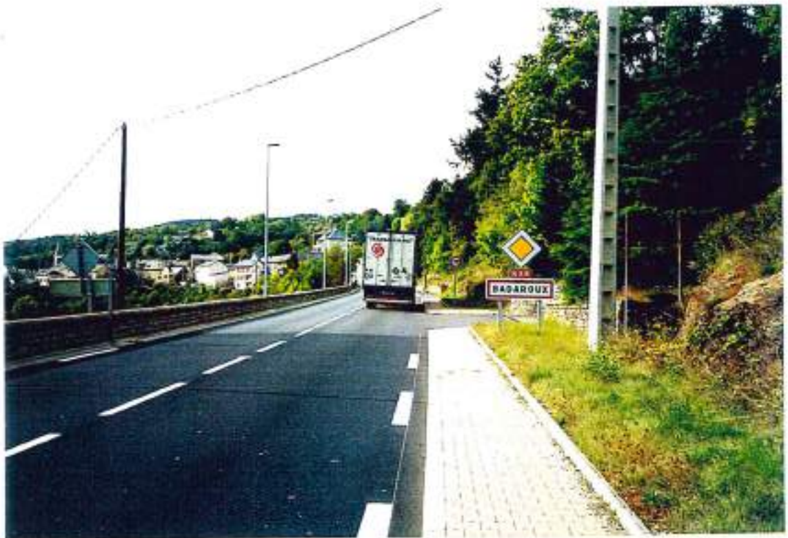
48-38 (n°33-16A) - La N88 à l'entrée de Badaroux (en venant du col de la Tourette): rétrécissement dangereux pour les cyclistes, 1 km à sécuriser
