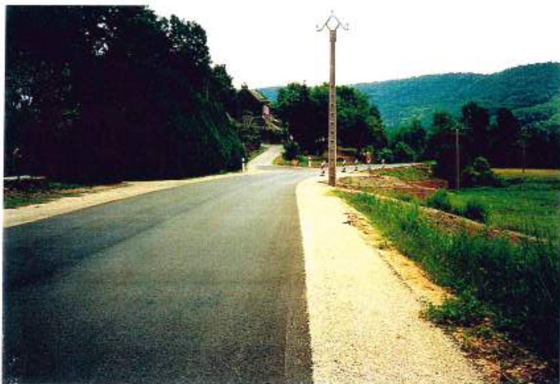
48-1 (n°26-1°-26A) - La D988 entre St-Laurent et Mas de Fraysse (chaussée de 6m) : à sécuriser par marquage de sur-largeurs
