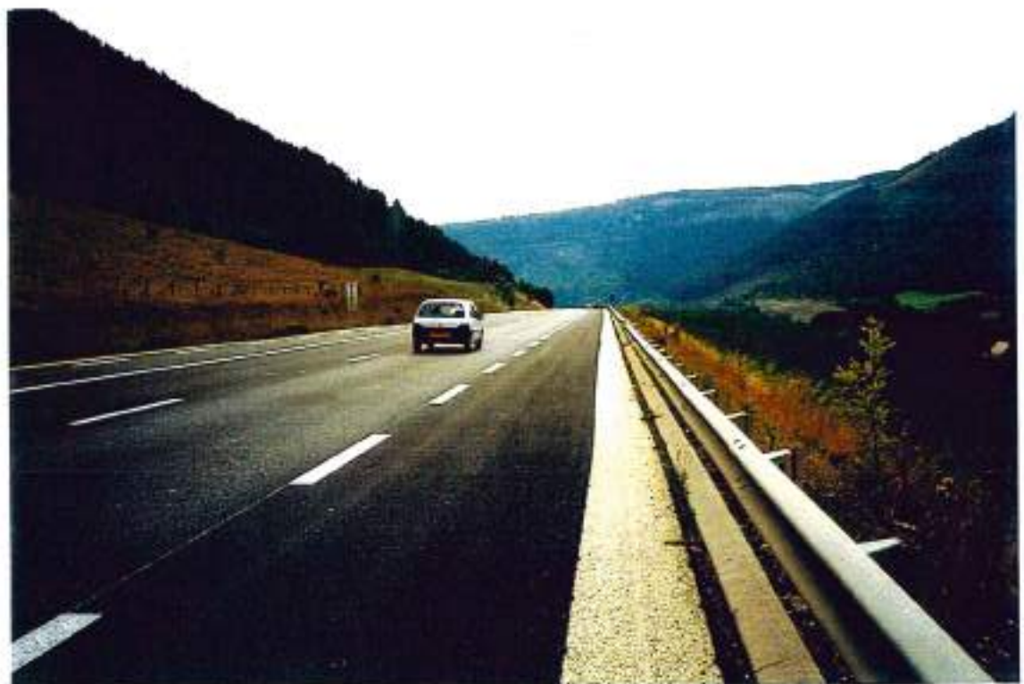
48-28 (n°30-27A) - La N88 entre Balsièges et Mende : belles sur-largeurs cyclables sur de grandes portions, mais avec des discontinuités
