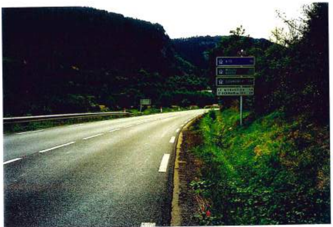
48-12 (n°27-2°-13A) - La N88 entre Chanac et Ressonches : bas-côté étroit et en mauvais état, "marche", ligne médiane discontinue dans la courbe
