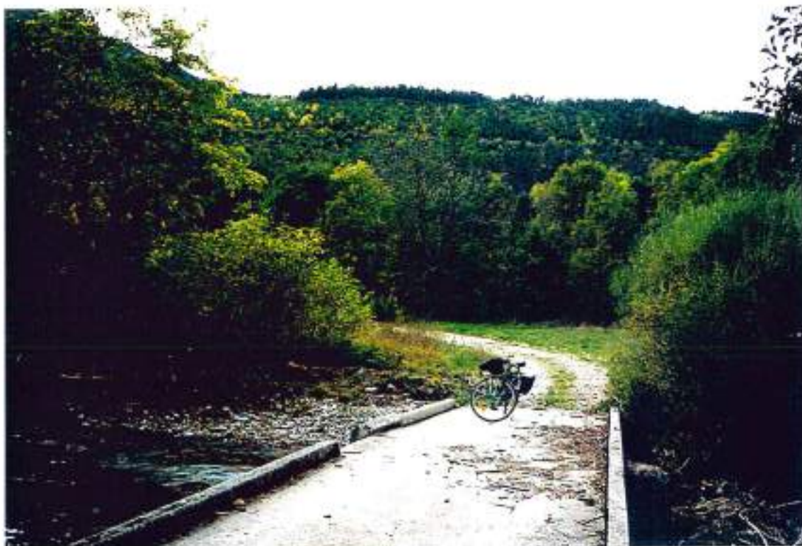
48-44 (n°33-11A) - Chemin entre la N88 et Nojaret : la passerelle en béton sur le Lot
