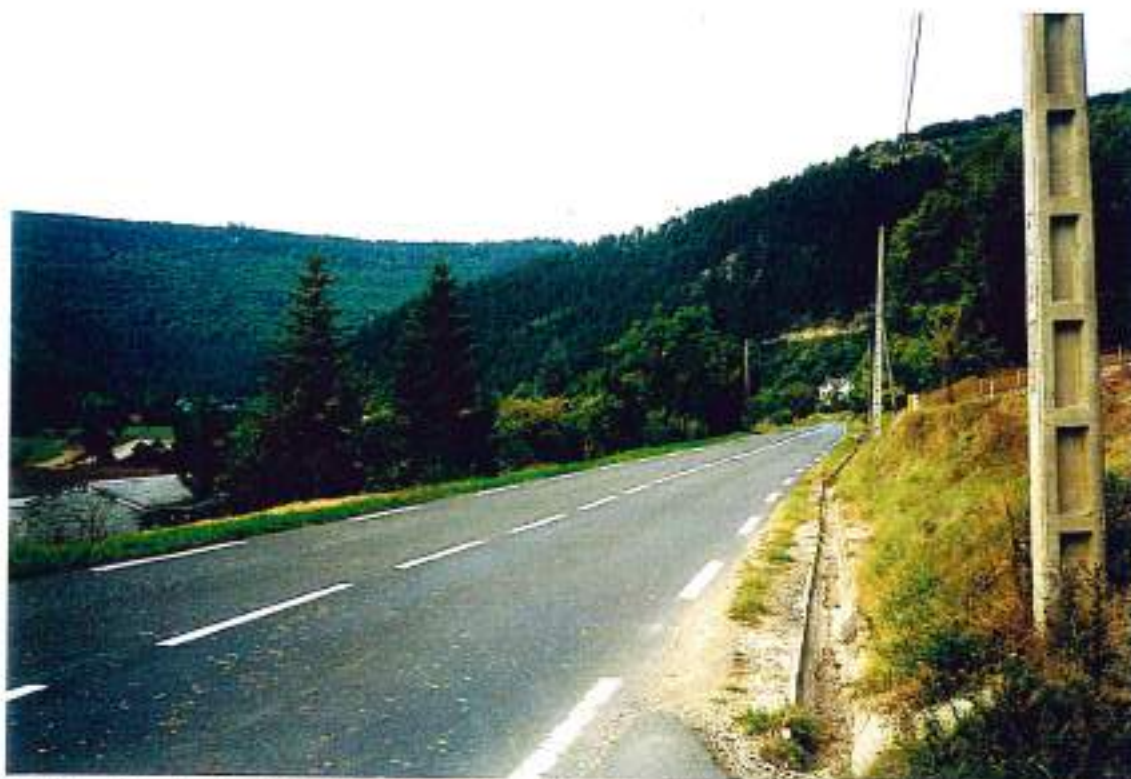
48-51 (n°30-10) - Boucle "cyclo", la N106 de Balsièges à Rouffiac : 2500 véh/j., à sécuriser (ici avant Rouffiac)
