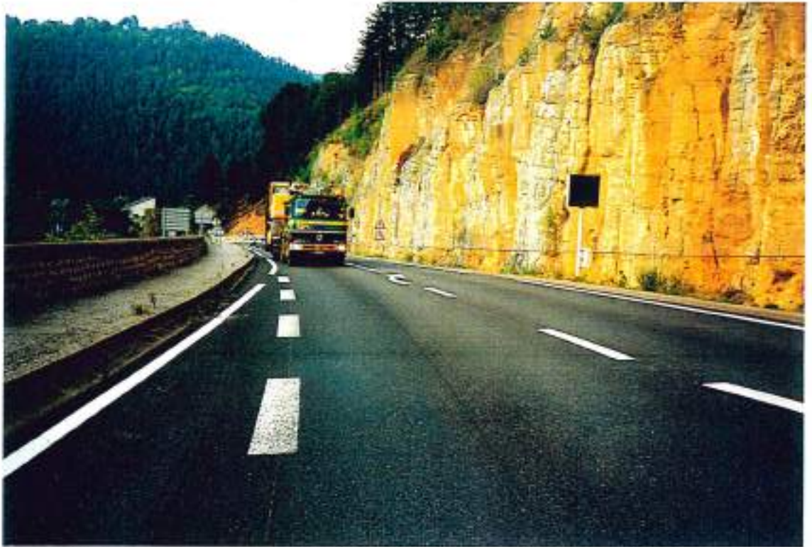
48-25 (n°29-29) - La N88 à la sortie de Balsièges : 0,8 km sans sur-largeurs jusqu'à le Luxembourg
