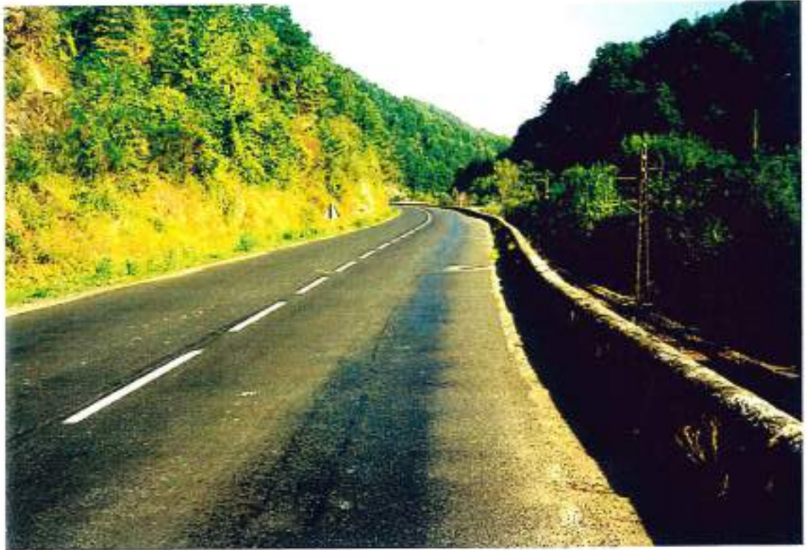
48-9 (n°27-1°-26A) - La N9 à 2 km de Banassac après le pont de Montferrand : étroite et dangereuse, à éviter par la création d'un itinéraire rive gauche
