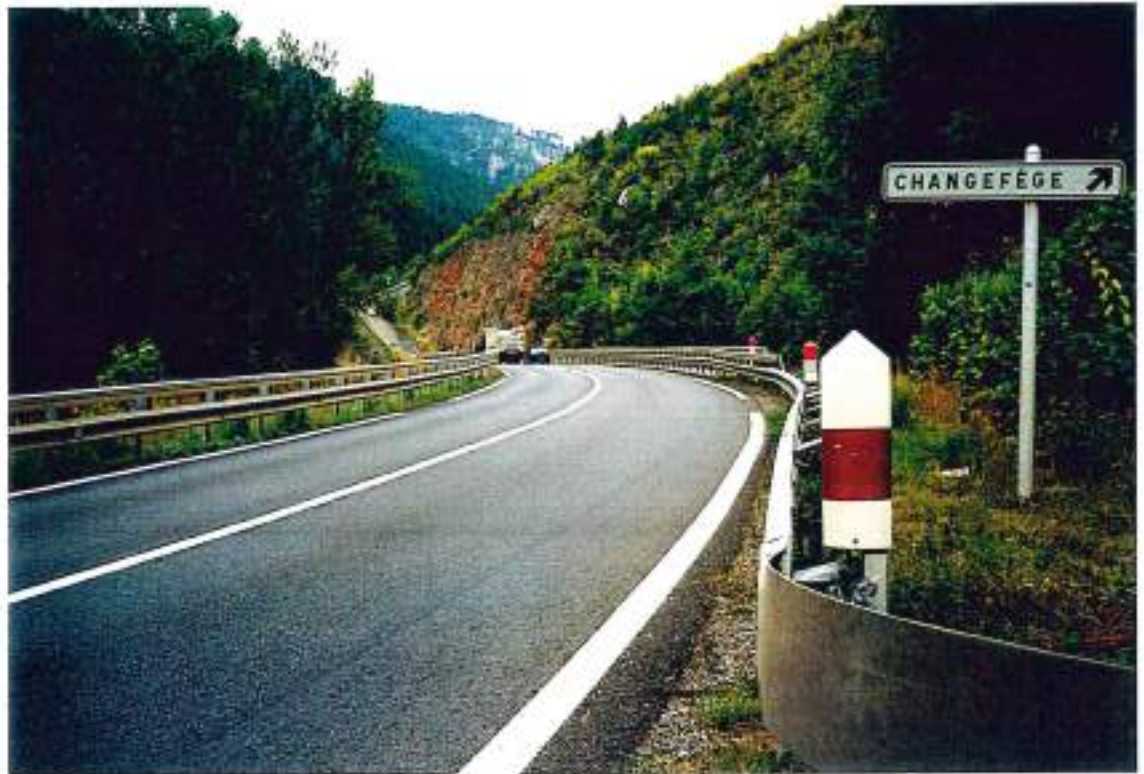
48-27 (n°30-32A) - La N88 entre Balsièges et Mende : passage étroit dangereux au pont sur le Lot (comme au pont sous la voie ferrée), discontinuité des sur-largeurs
