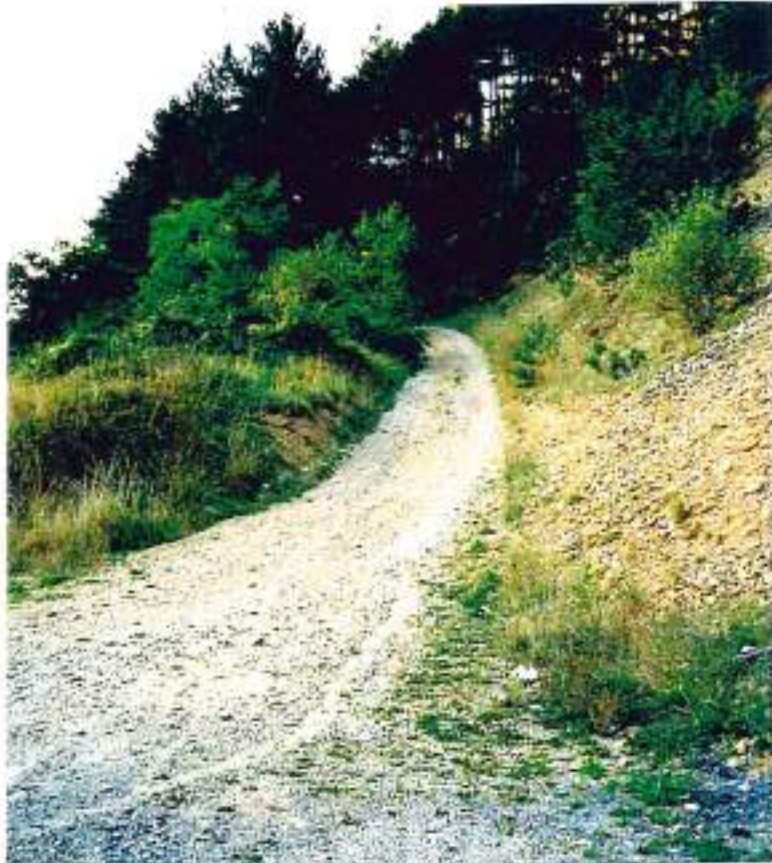
48-29 (n°29-28) - La route forestière de la vallée du Lot entre Balsièges et Mende : le début sur la N106 en face de les Fonts (revêtement dégradé à cause de la pente)
