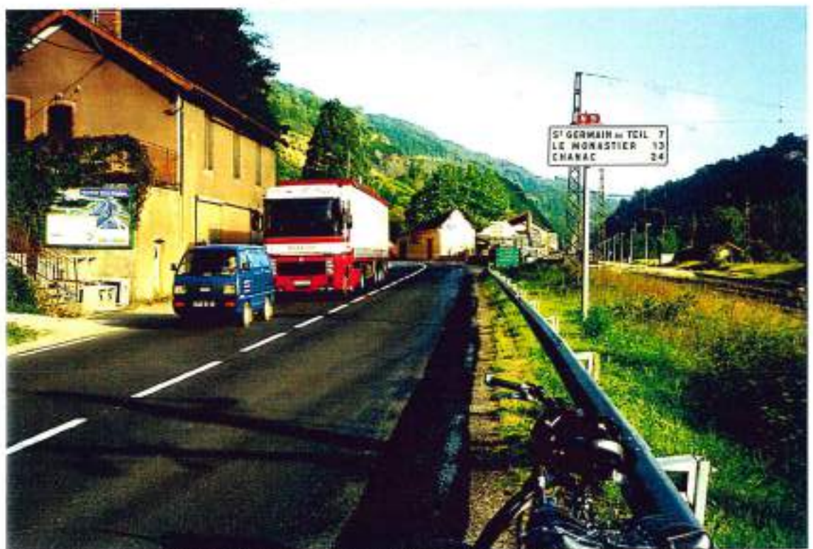
48-8 (n°26-1°-22A) - La N9 à La Mothe-Banassac: trafic élevé, poids-lourds, ligne médiane discontinue dans les virages, absence de bas-côtés ou sur-largeurs cyclables
