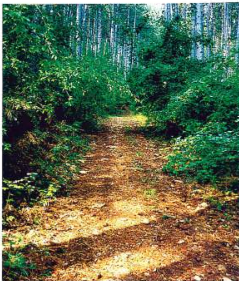
48-19 (n°31-3A) - La route forestière du ravin du Choizal à aménager pour éviter la D986: descente raide au pied du "Lion de Balsièges"
