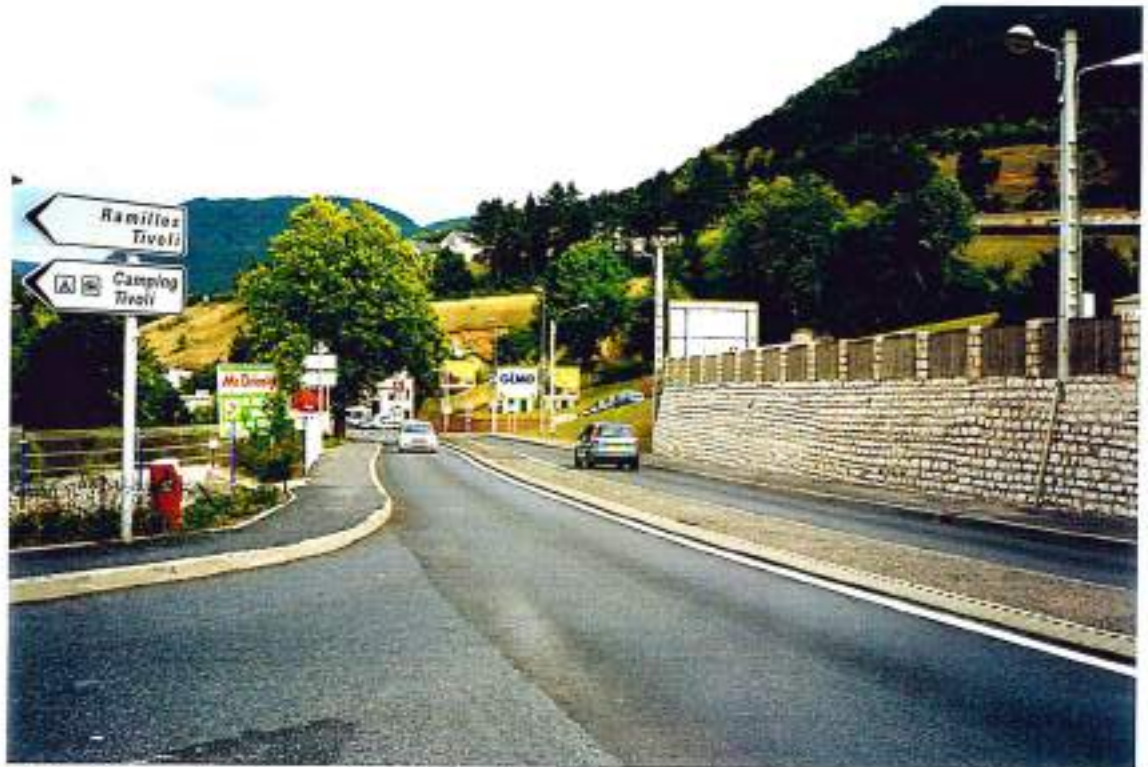
48-26 (n°30-25A) - La N88 à l'entrée-sortie de Mende : absence d'aménagement cyclable sur 1 km, ici terre-plein central et danger pour les cyclistes
