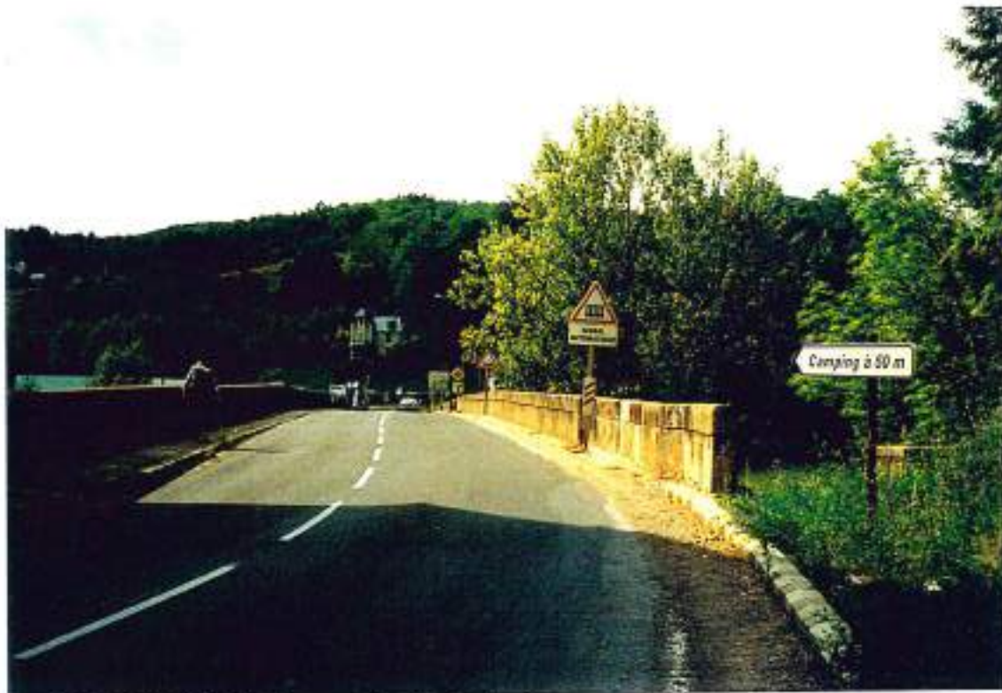
48-3 (n°26-2°-13A) - Le pont de La Mothe-Banassac : à sécuriser
