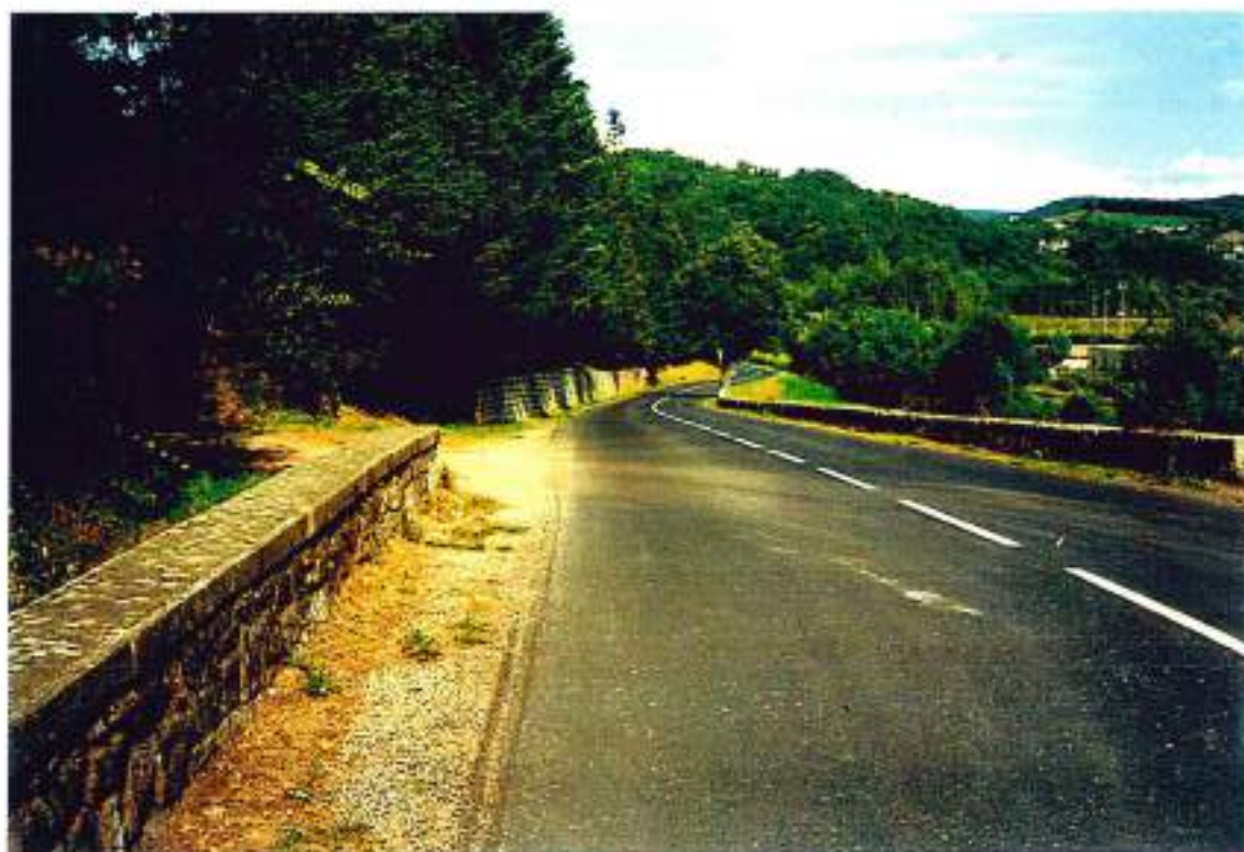
48-2 (n°26-2°-14A) - La D988 entre le passage à niveau Le Vialá et La Mothe-Banassac (chaussée de 5,40m) : à sécuriser par élargissement et sur-largeurs
